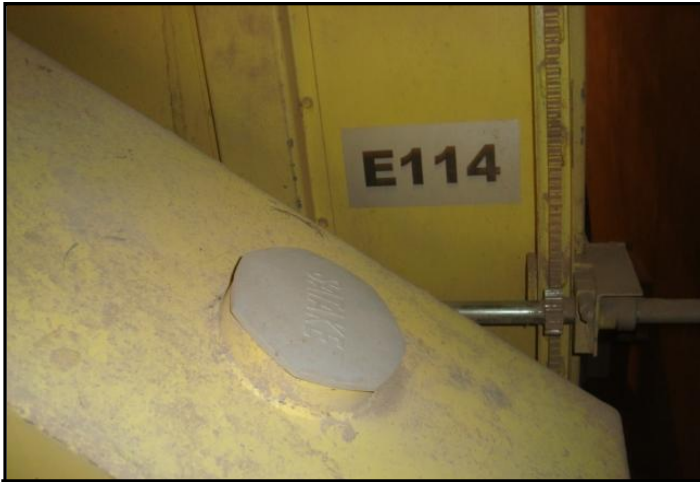
Boortmalt- Elevator E114
